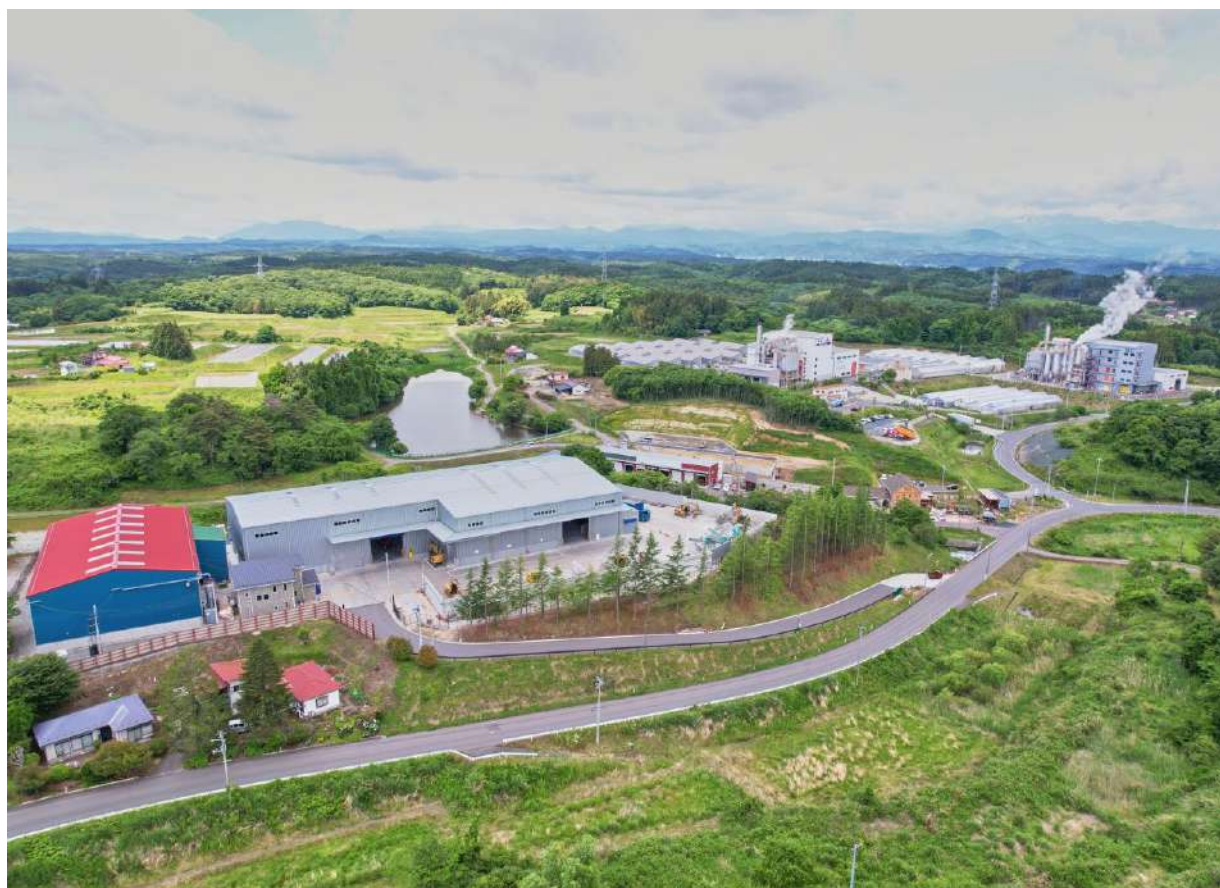
【株式会社築館クリーンセンター】 高森RCS施設拡張
